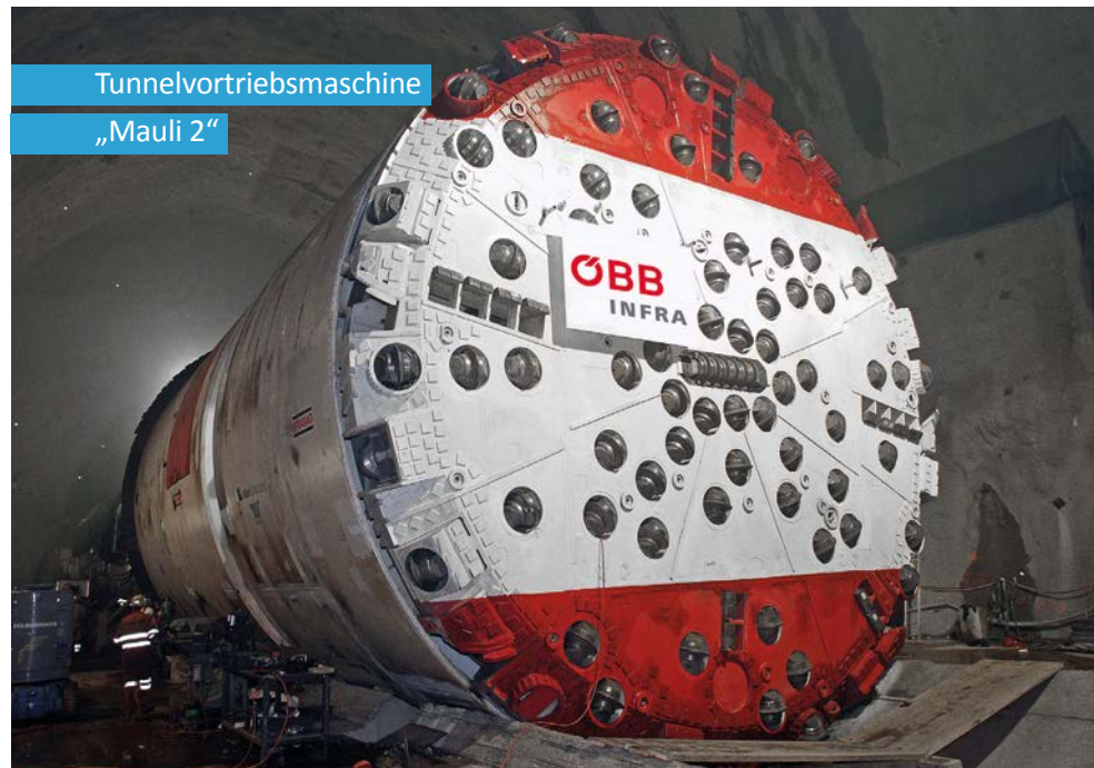
Abbildung: Beim Rohbau-Baulos KAT 2 eingesetzte Doppelschild-Tunnelvortriebsmaschine
